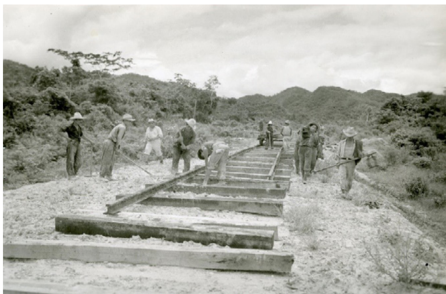
Tenosique. Tendido de vía en el kilómetro 335/500, entre Río Usumacinta y Río Polevá 1
