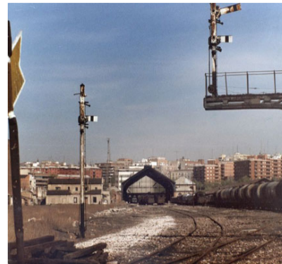
Puente de señales y marquesina de la estación de las Delicias, sede del Museo del Ferrocarril de Madrid. FFE.
