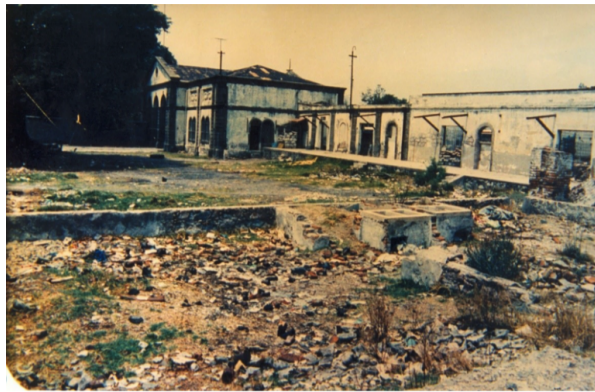
La estación Puebla del Ferrocarril Mexicano en total abandono, Ca. 1980. Colección Donaciones al CEDIF. Secretaría de Cultura/CNPPCF/CEDIF.
