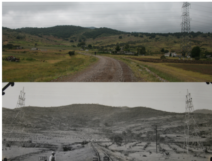
20. Línea HD, cables de alta tensión entre las estaciones de Otlimulco y Ventoquiya, en la actualidad y en 1928.
