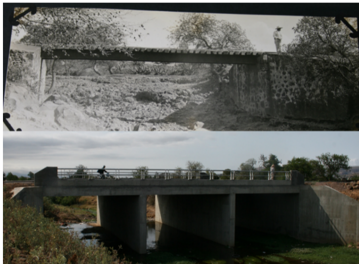
17. Puente 147, entrada a Cuautepec de Hinojosa, Hidalgo.
