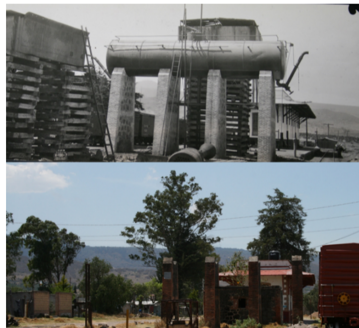
13. Patios de la estación Ventoquipa.
