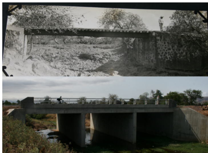
17. Puente 147, entrada a Cuautepec de Hinojosa, Hidalgo.
