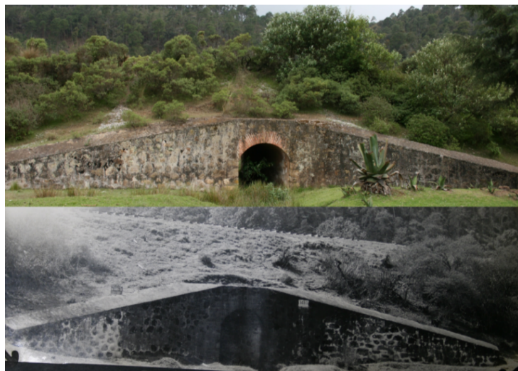
18. Alcantarilla H-149-D o Alcantarilla 089, entre las estaciones de Xocopa y Cima de Togo.
