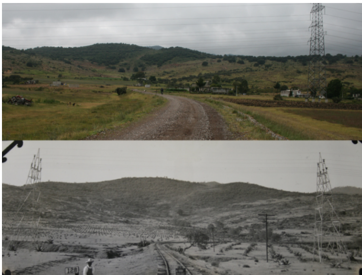
20. Línea HD, cables de alta tensión entre las estaciones de Otlimulco y Ventoquiqa, en la actualidad y en 1928.
