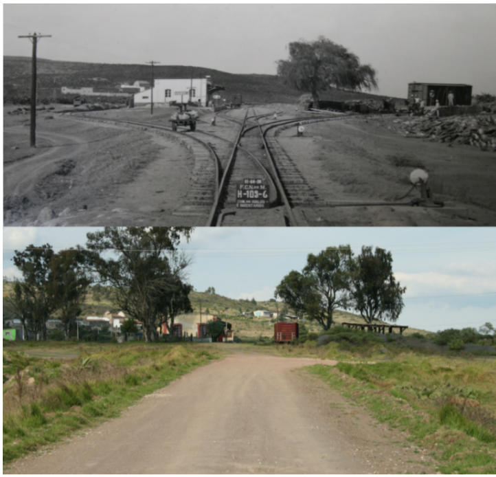
11. Vista del tendido de vía de la estación Somorrié.
