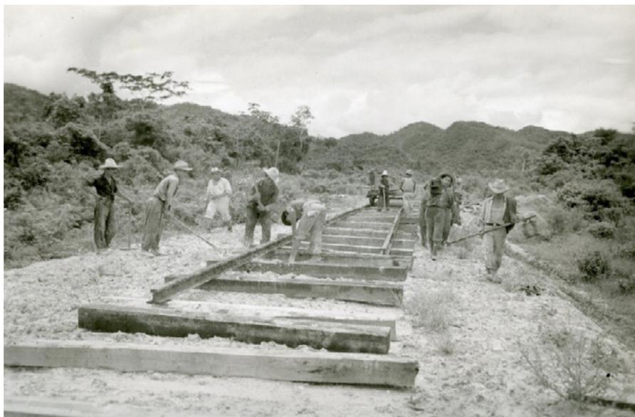
*Tenosique. Tendido de vía en el kilómetro 335/500, entre Río Usumacinta y Río Polevá <sup>1</sup>*
