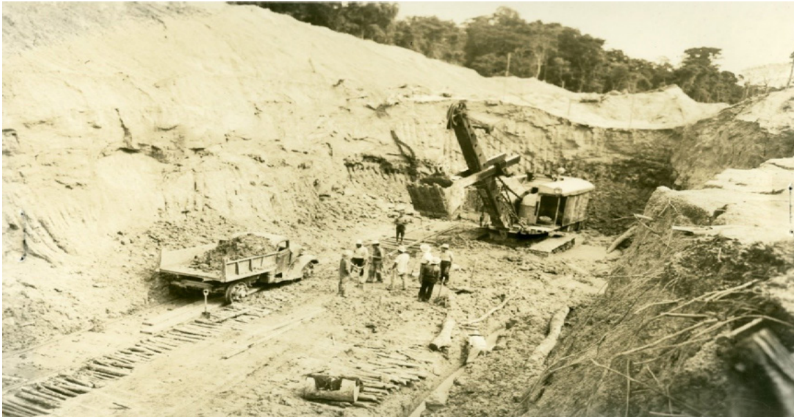
Pala mecánica en el corte del kilómetro 47 de la división Puerto México (Nótese lo fangoso del terreno). 10
