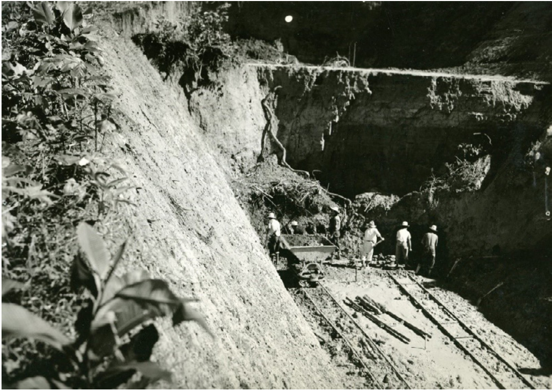
Foto 10. Trabajos en el corte en el kilómetro 45 1
