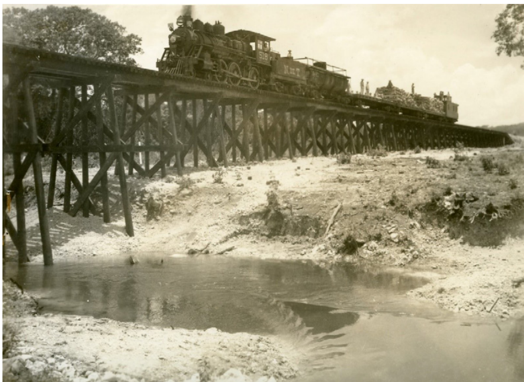
Foto 36. Puente sobre el río Champotón, sobre caballetes de madera
