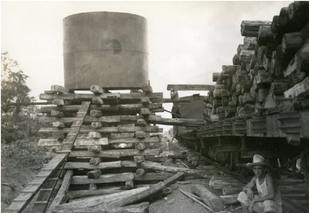
Foto 24. Campamento de Pixoyal. Instalación de un tanque de agua
