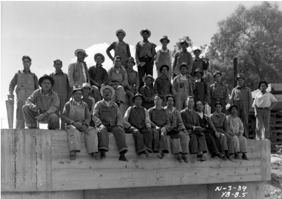
Grupo del personal y operarios encargados de obras de construcción del puente sobre el Gran Canal y el Canal de San Lázaro, 1939. Fondo FNM, Sección Comisión de Avalúo e Inventarios. CEDIF, CNPPCF, Secretaría de Cultura.
