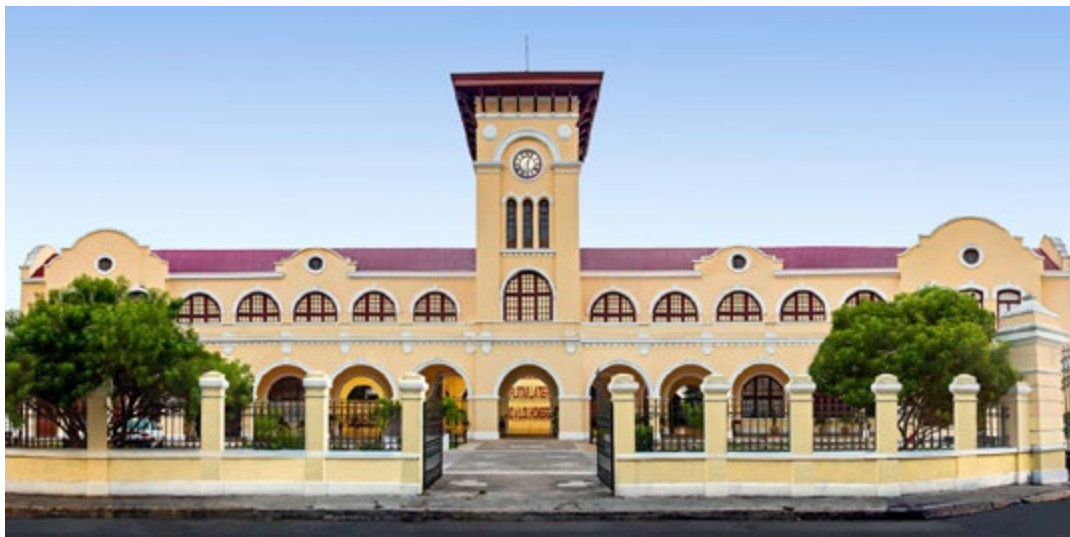
Fachada de la Estación Central de Ferrocarriles de Mérida, actualmente la Escuela de Artes de Yucatán (ESAY) Fotografía: http://www.esay.edu.mx/wp/
