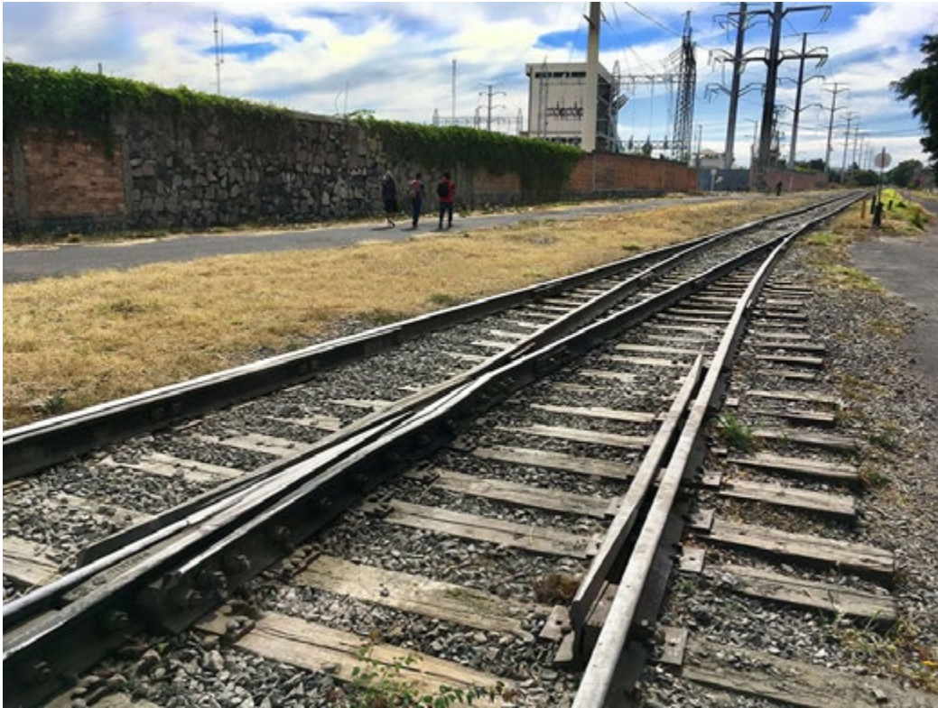
Vista actual de la vía férrea en Guadalajara, a la altura de la compañía La Vidriera. Fotografía: Alberto Paz Bustamante, mayo 2019.
