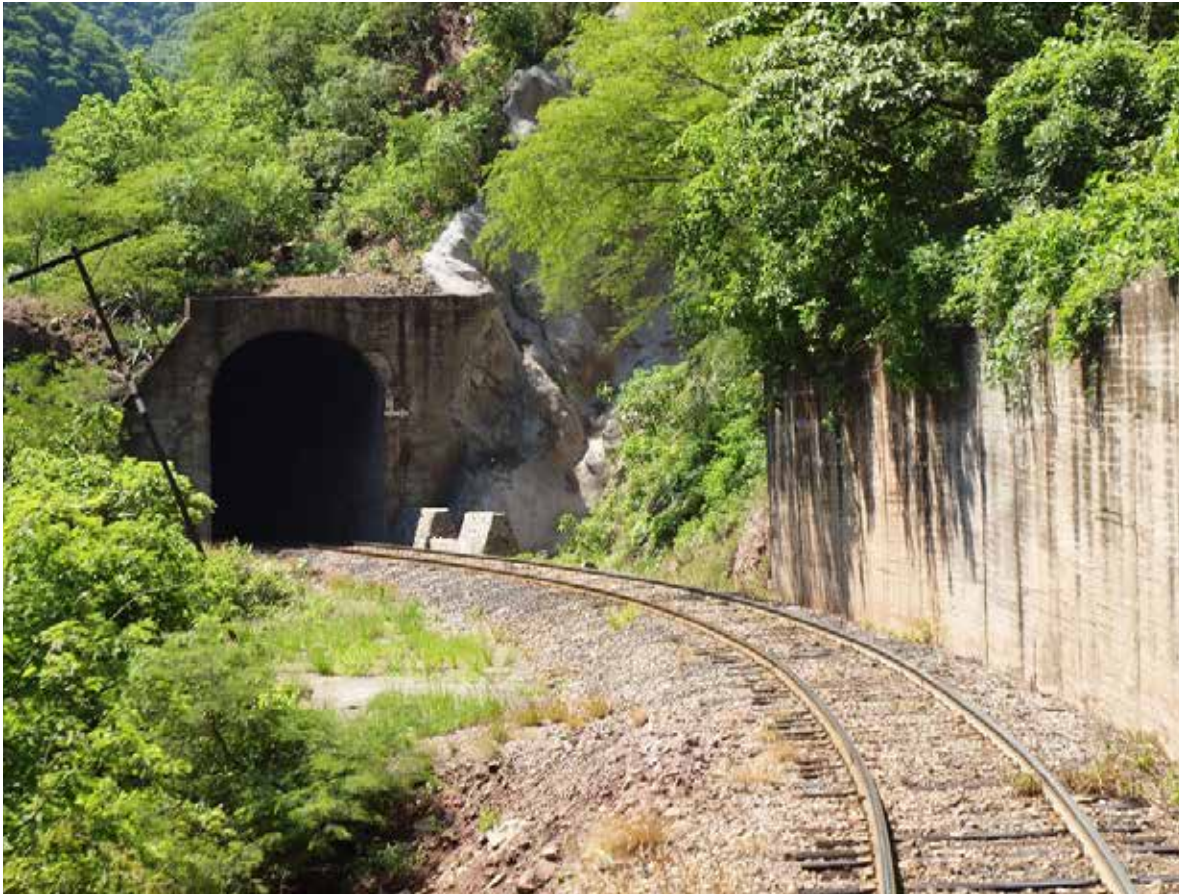
Túnel N°. 59A (30-07-2012)
