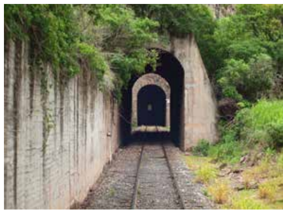
Túnel N°. 42A (28-07-2012)
