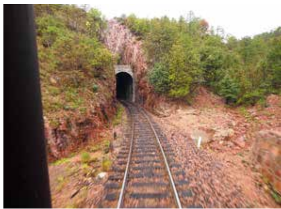
Túnel N°. 4A (30-07-2012)
