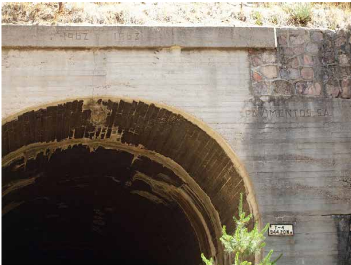
Fecha de construcción del Túnel N° 4, 1962-1963 (29-03-2013)
