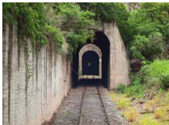
Túnel N°. 42A (28-07-2012)
