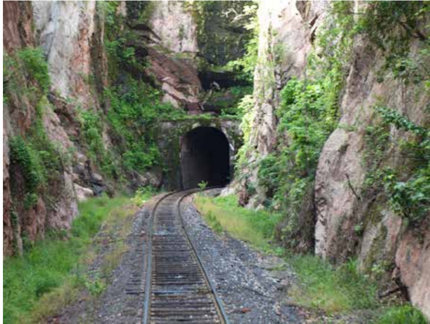
Túnel N°. 86 El Descanso (30-07-2012)
