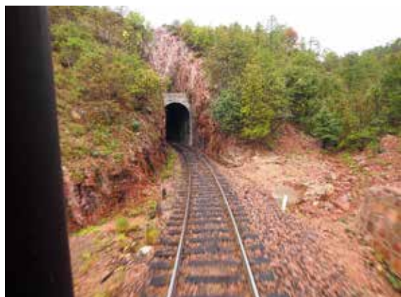
Túnel N°. 4A (30-07-2012)
