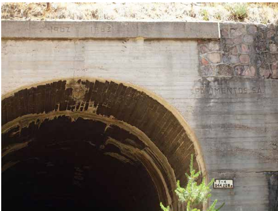
Fecha de construcción del Túnel N° 4, 1962-1963 (29-03-2013)
