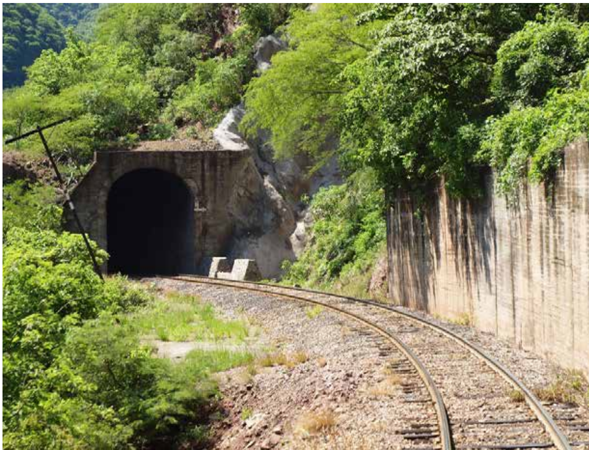
Túnel N°. 59A (30-07-2012)
