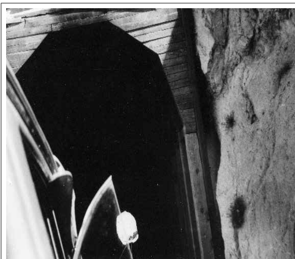
Túnel N° 1 con portales de madera (04-07-1957) CEDIF.
