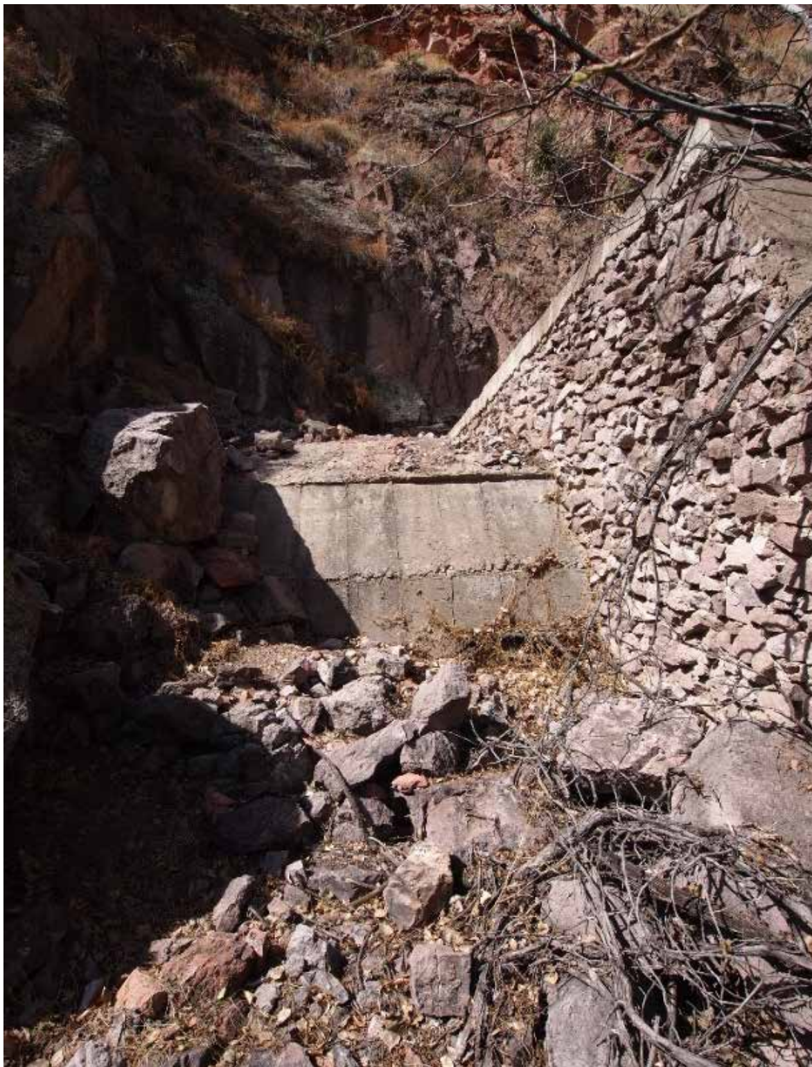
Salida del túnel N° 10, con su extensión para proteger la vía de derrumbes (28-03-2013)
