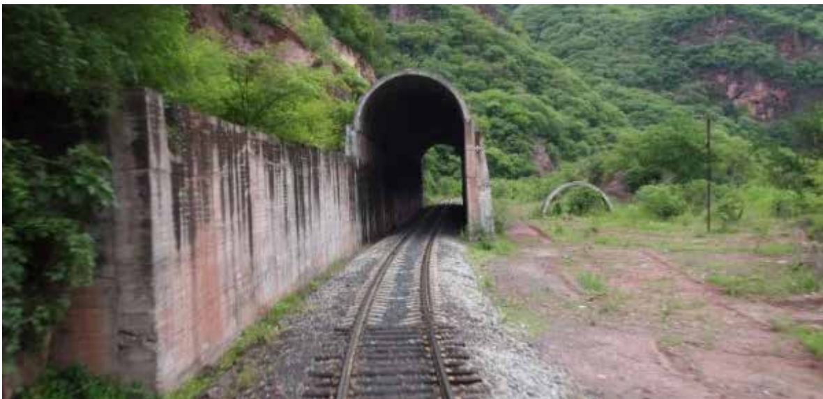
Túnel N°. 73A salida (28-07-2012)
