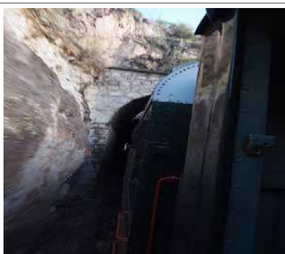
Túnel N° 1 con portales de mampostería (28-07-2012)
