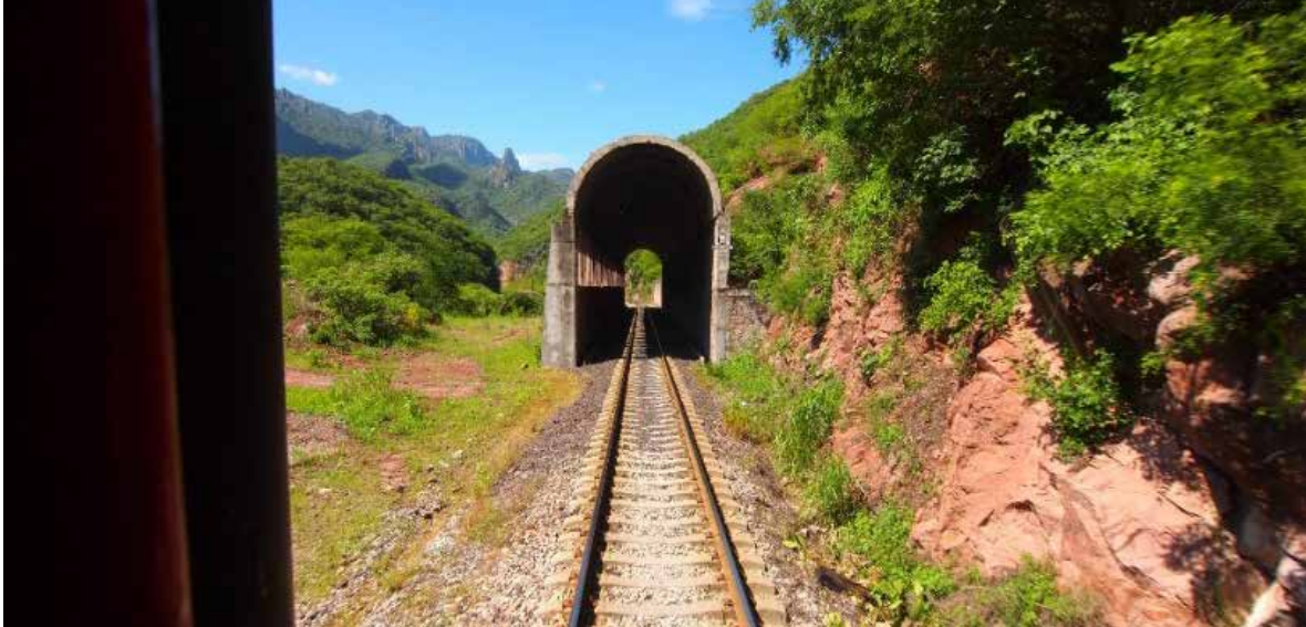
Túnel N°. 73A entrada (30-07-2012)
