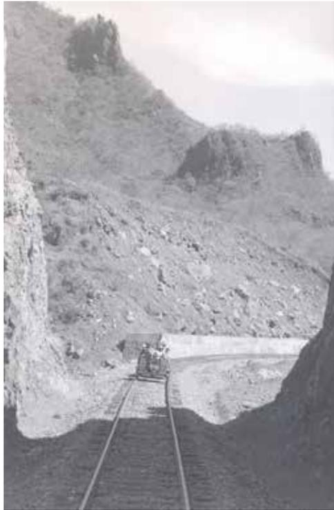
Cuadrilla saliendo del Túnel N° 70 con Túnel N° 69 al fondo. Túneles construidos en mampostería para proteger el deslave de la montaña.
