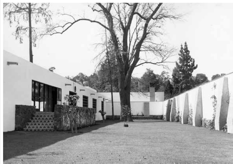
Hospital San Fernando de FNM en la Ciudad de México, México. 1963. Fondo Ferrocarriles Nacionales de México, Sección Revista Ferronales. Secretaría de Cultura, CNPPCF, CEDIF.
