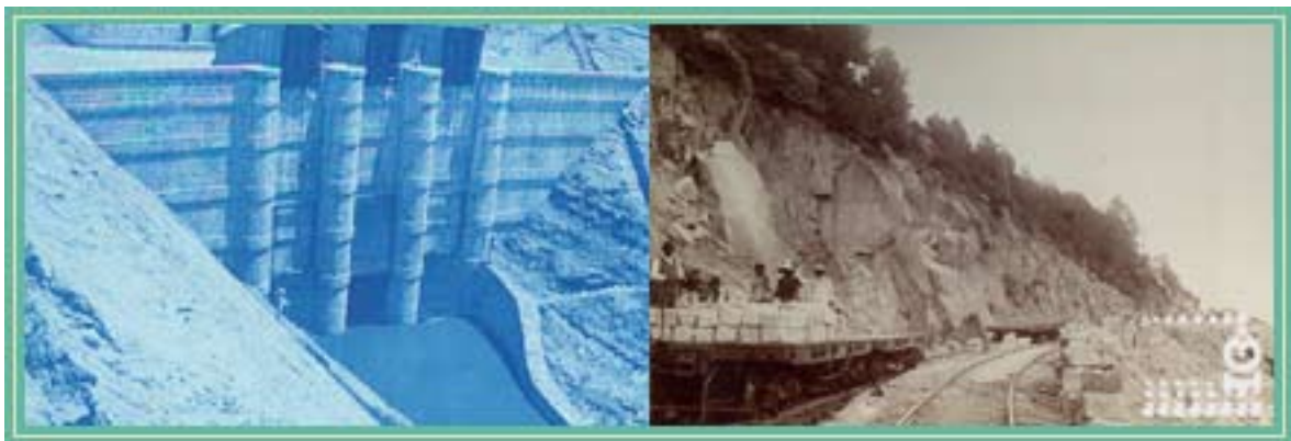
1. Elevación anterior de la presa
