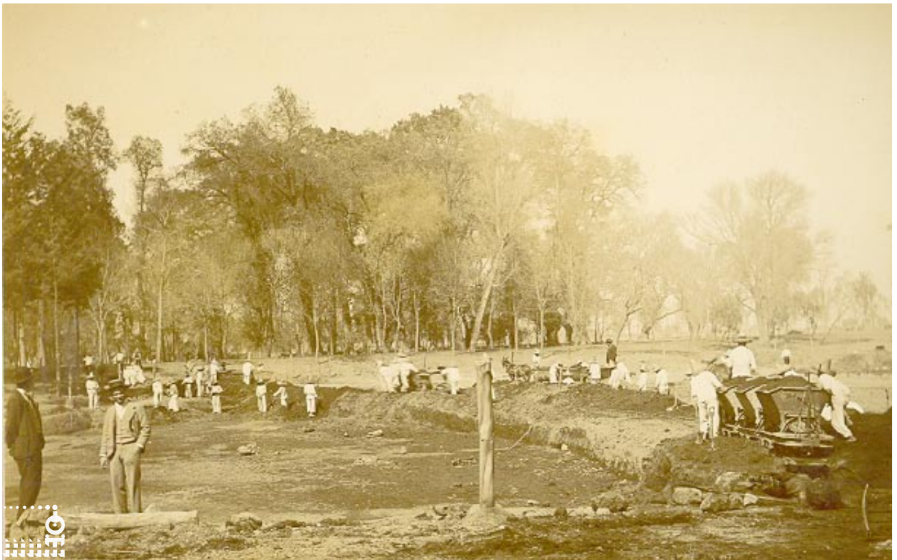
Ferrocarril del bosque de Chapultepec, obra dirigida por el ingeniero de calzadas Francisco Cerro, Excavación gran lago (lado sur). Imagen tomada del Álbum fotográfico Chapultepec, 19 de mayo de 1900 a 11 de abril de 1901 . Biblioteca especializada/CONACULTA/CNPPCF/MNFM/CEDIF
