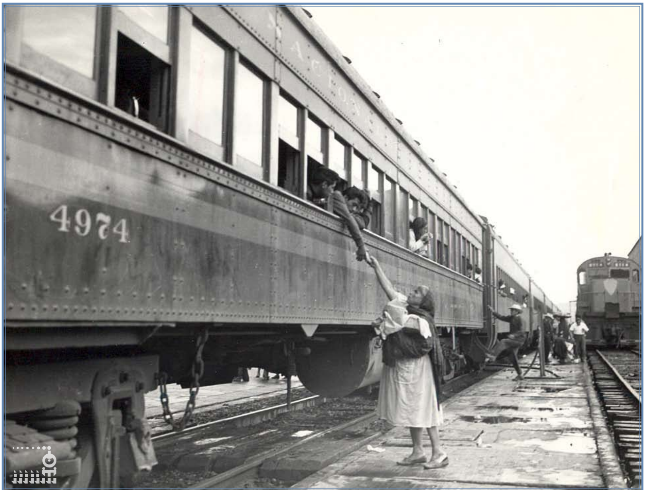
Andén de una estación, ca. 1975. Fondo Ferronales. Fototeca. CONACULTA/CNPPCF/CEDIF
