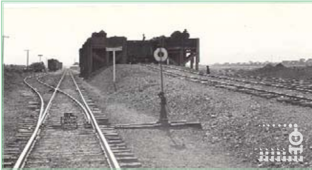
Detalle de vía a la entrada al patio de Barroterán. Vía elevada con carboneras madera y línea a Muzquiz, (a la derecha). Vista al sur, 1929. 45
