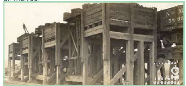
Carbonera de madera con seis tolvas para el servicio de locomotoras, Rosario, 1929. 49
