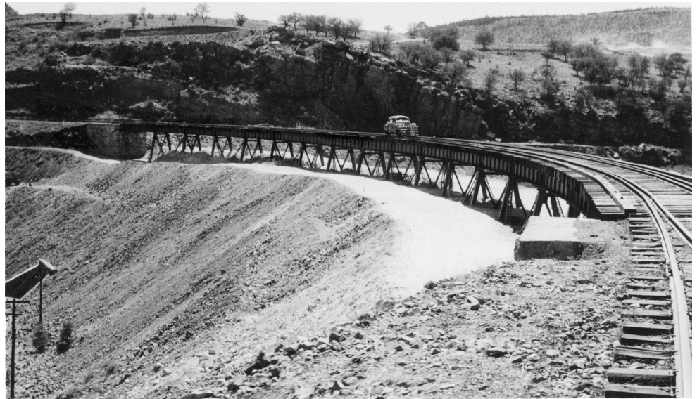
Puente de estructura metálica en el kilómetro 365, paso superior, traveses compuestos de lámina remachada sobre 16 caballetes metálicos y estribos de mampostería. 1957. Colección: donaciones al Cedif. Secretaría de Cultura, CNPPCF, Cedif.
