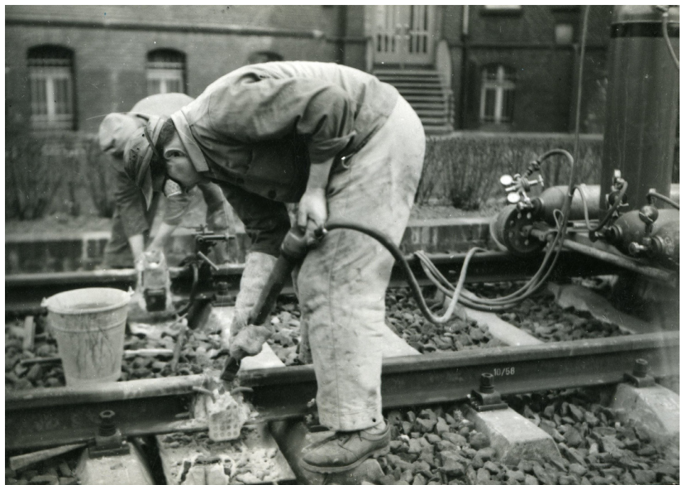
“Soldadura de rieles”
