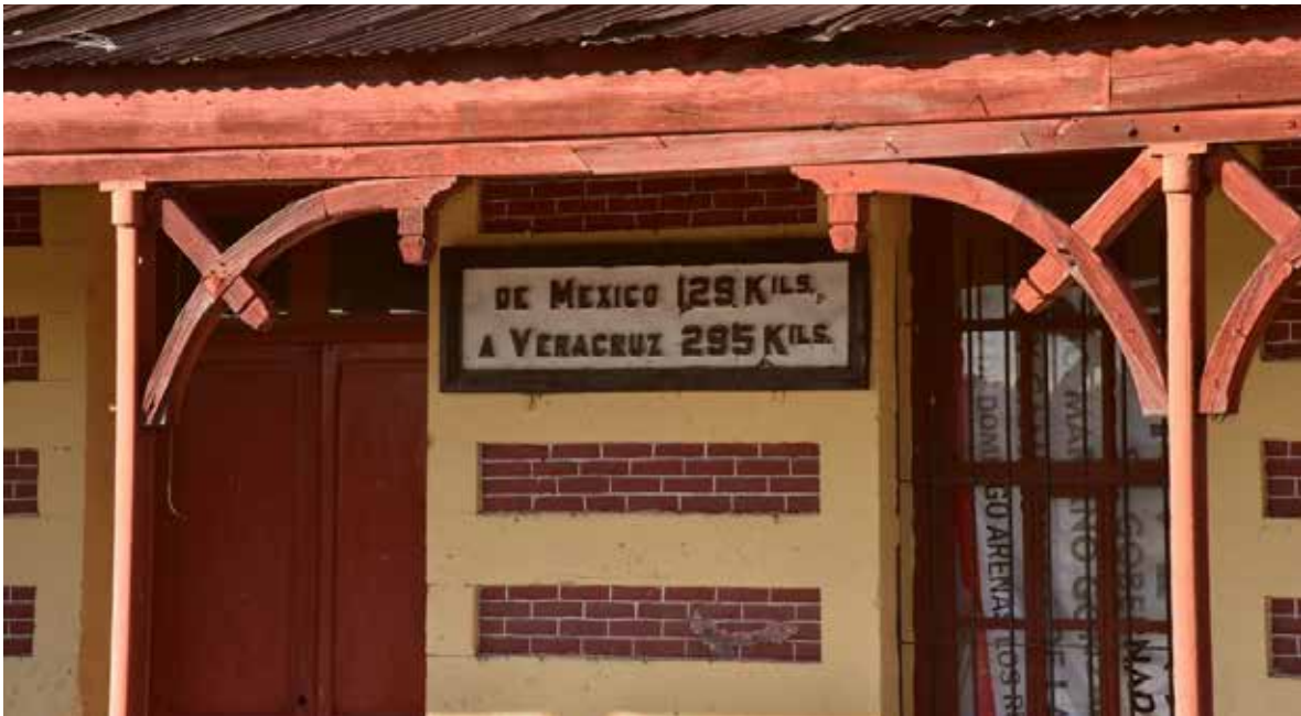
Fotografía 3: Detalle de la fachada de la Estación de Muñoz. Autoría y autorización para reproducción: Nazim Avedaño Ramos.
