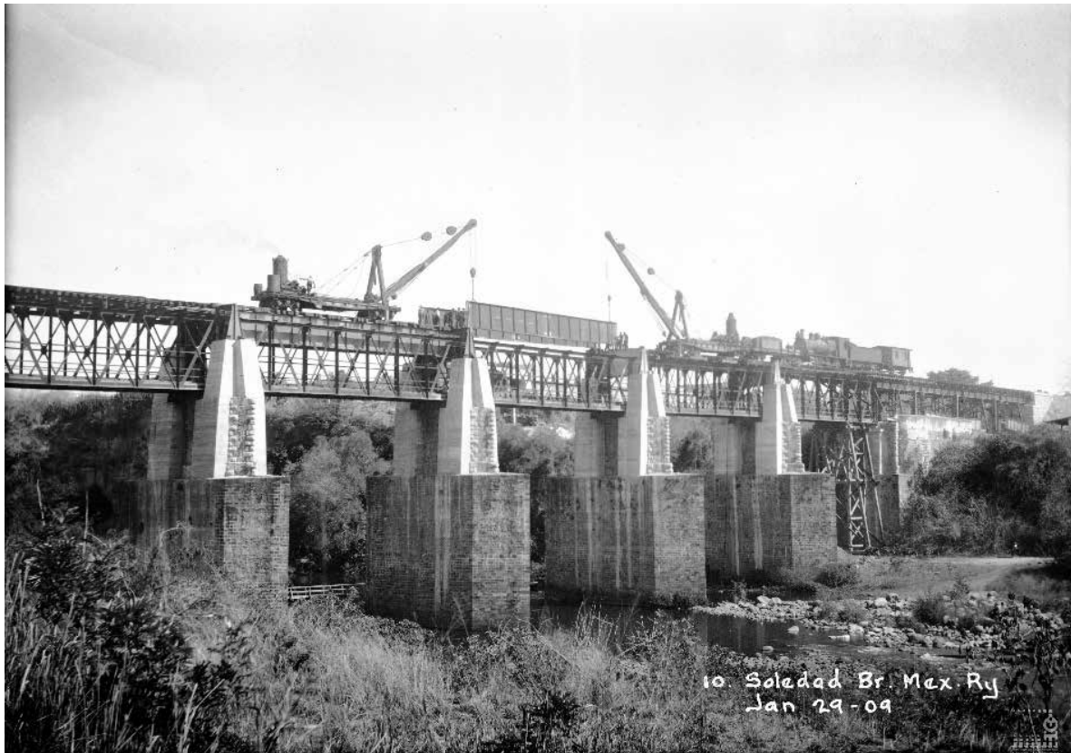
Fig. 4 El Puente de la Soledad durante su reforma el 29 de enero de 1909. Se renuevan las vigas superiores de la vía del ferrocarril. Fondo Ferrocarril Mexicano. CEDIF, CNPPCF, Secretaría de Cultura.
