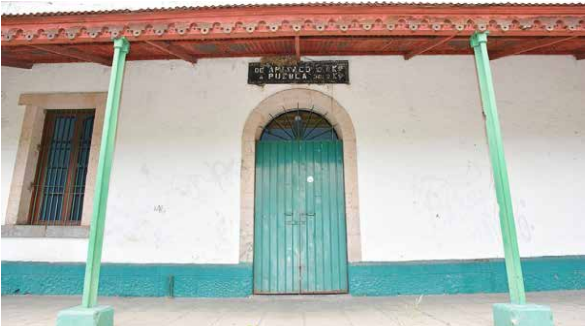
Fotografía 5: Detalle de la fachada de la Estación de Santa Cruz Tlaxcala. Autoría y autorización para reproducción: Nazim Avedaño Ramos.
