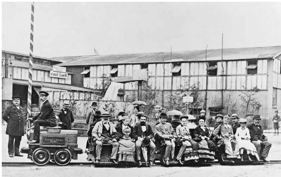
Imagen 1. La locomotora eléctrica de Ernst Werner M. Von Siemens (1879). Wikimedia Commons.
